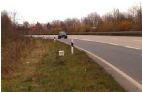
事故现场照片1：入口处及加速道
