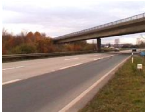
事故现场照片2：发生事故的路段
